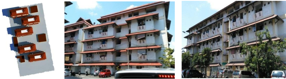
Gambar 2. Eksisting Bangunan Rumah Susun Aparna
