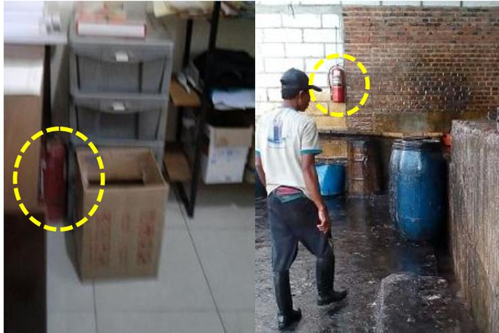
Gambar 1. Kondisi eksisting perletakan APAR pada bangunan
