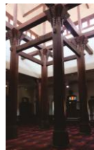
Gambar 9. Struktur kolom utama bangunan masjid
