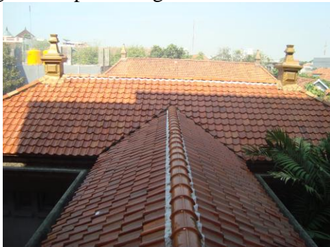
Gambar 8. Atap bangunan induk
