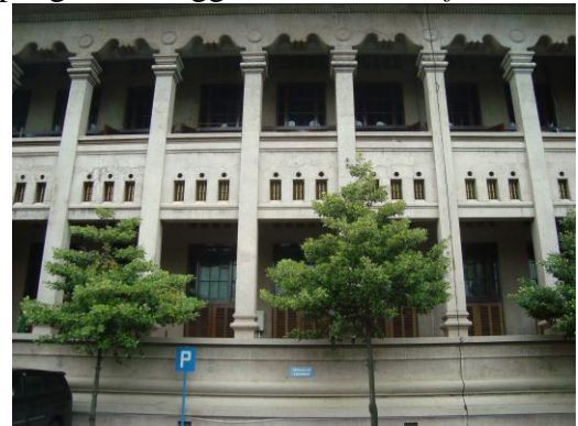
Gambar 9. Kolom eksterior bangunan
