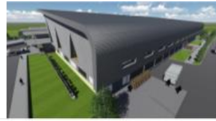
Material atap menggunakan aluminium metal deck.
