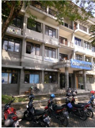
Gambar 1. Gedung UKM Universitas Brawijaya
